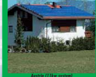
Austria (11kw system)
